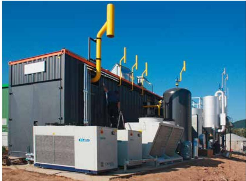
*Biogas muss in solchen Anlagen gereinigt werden, damit es als Biomethan in das Gasnetz eingespeist werden kann.*
