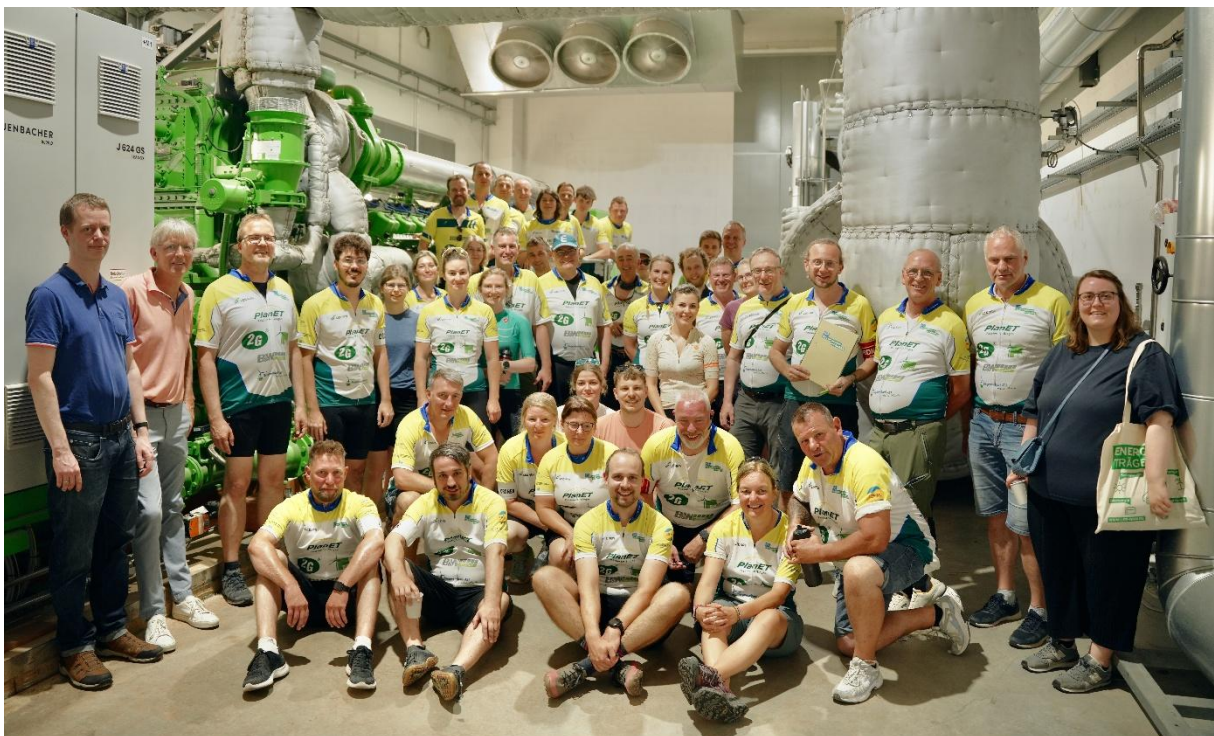
Abbildung 15: Teamfoto des Fahrerfeldes 2026 vor dem Spitzenlast-BHKW der Energiezentrale Bersenbrück (Foto: Felix Peschko, Berlin)
