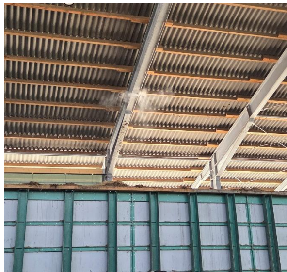
Abbildung 9: Die geruchsmindernde Verneblung über einem Schubbodencontainer zur Fütterung von Mist.
