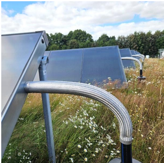
Abbildung 45: Grün eingebettet sammeln die Solarthermie-Module in Lübeck-Moisling die Solarwärme ein und liefern sie an einen Wärmespeicher, bevor es ins nahegelegene Wärmenetz geht.
