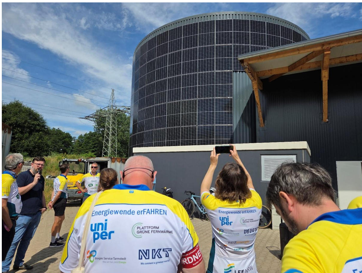
Abbildung 13: Effiziente Ausnutzung von Flächen: Selbst die Außenwand des zentralen Wärmespeichers wird in Alfhausen zur Stromerzeugung genutzt.
