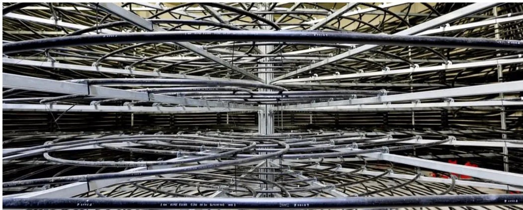
Beispielhafte Darstellung des Inneren eines Eisspeichers mit Kunststoffrohren (Quelle: Bundesverband Wärmepumpe (BWP) e.V.)
